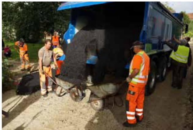
Sicheres und gefahrloses Befüllen von Schubkarren !
