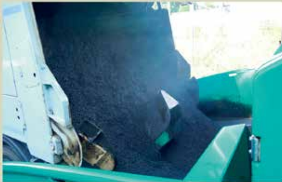
B138-Pyrnpaßstr._Asphalteinbau mit Abschiebefahrzeuge
