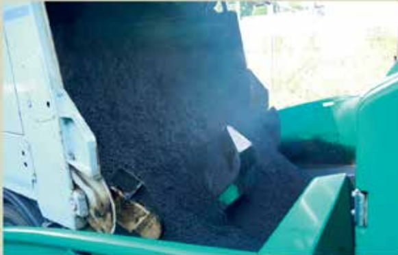
B138-Pyrnpaßstr._Asphalteinbau mit Abschiebefahrzeuge
