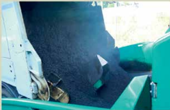
B138-Pyrnpaßstr._Asphalteinbau mit Abschiebefahrzeuge
