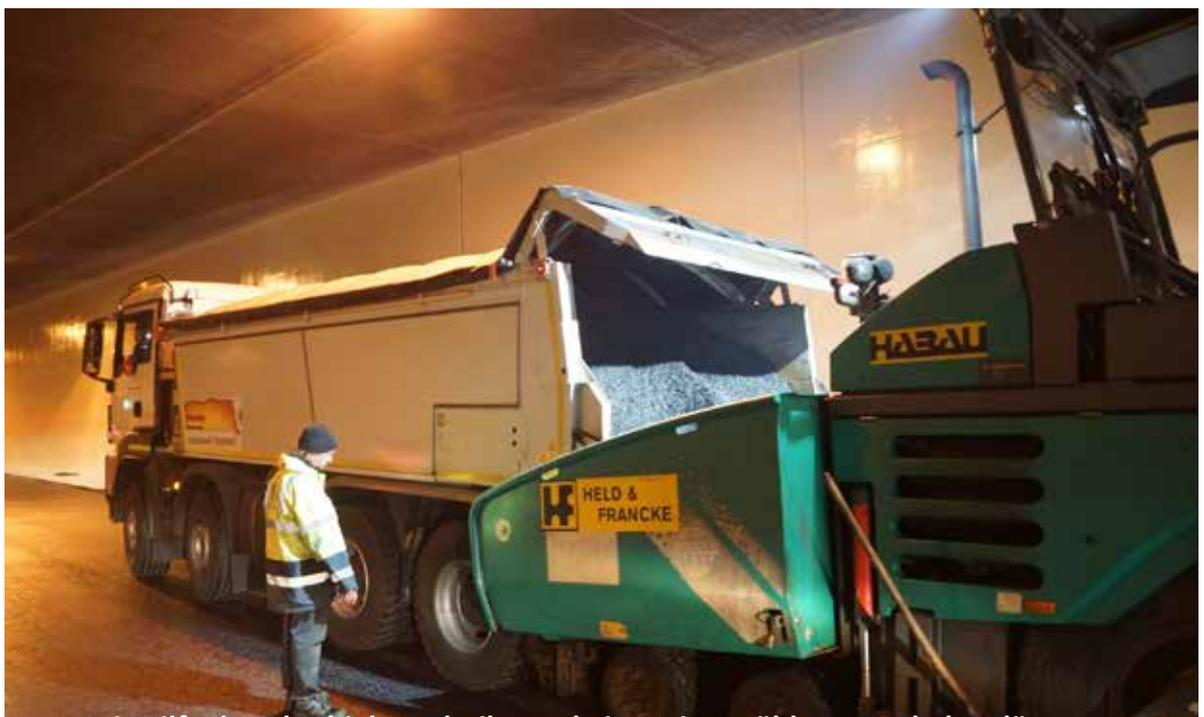
„Mit Hilfe der Abschiebetechnik wurde im Kaisermühlentunnel, dem längsten Straßentunnel Wiens, ca. 150.000 m<sup>2</sup> Asphalt mit 50.000 t Mischgut eingebaut.“
