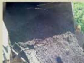
Die Folgen der Krustenbildung (Entmischung/Kalte Nester) werden mit Abschiebefahrzeugen durch laufende Durchmischung beseitigt.
