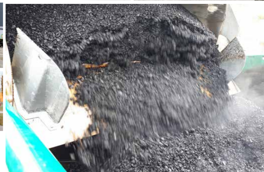
Płytki centrujące kierują asfalt pośrodku do zbiornika rozścielacza, ograniczając segregację mechaniczną/termiczną
