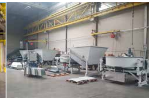
Końcowy montaż węzłów betoniarskich
