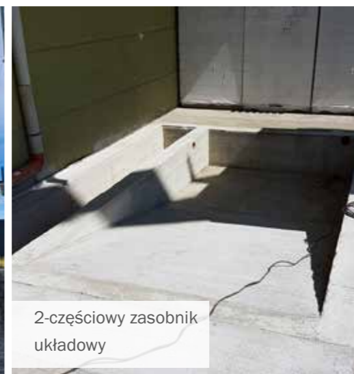
Zagłębienie pod taśmą przenośnika
